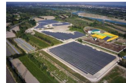
Ferme photovoltaïque ©Châteaurenard
